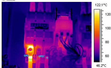
Rysunek 17.9 Obraz termograficzny urządzenia elektrycznego znajdującego się w pomieszczeniu (2).
