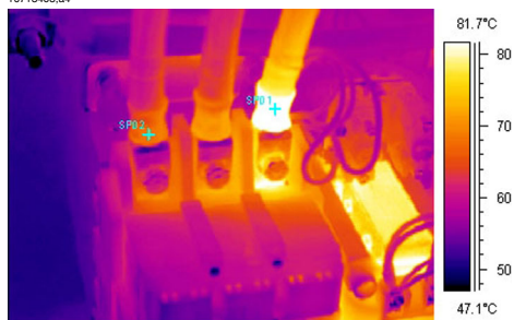
Rysunek 17.8 Obraz termograficzny urządzenia elektrycznego znajdującego się w pomieszczeniu (1).
