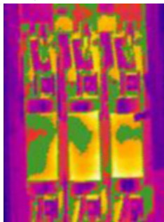
Rysunek 17.6 Izoterma na termograficznym obrazie skrzynki bezpieczników
